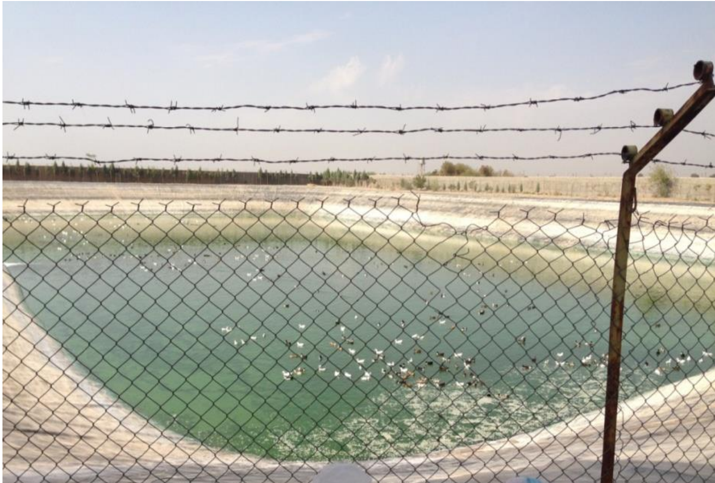
استخر ذخیره آب
